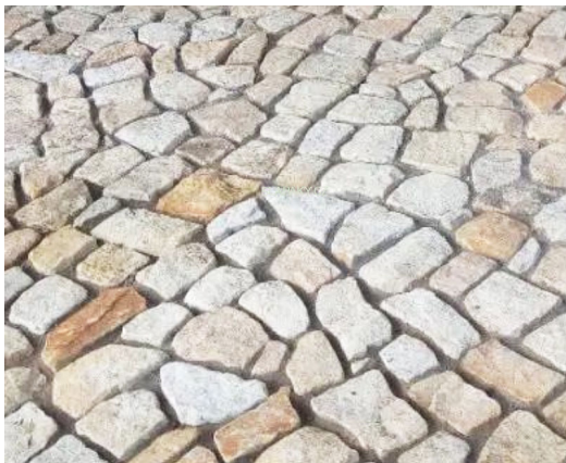
referenční provedení dlažby před zaspárováním
